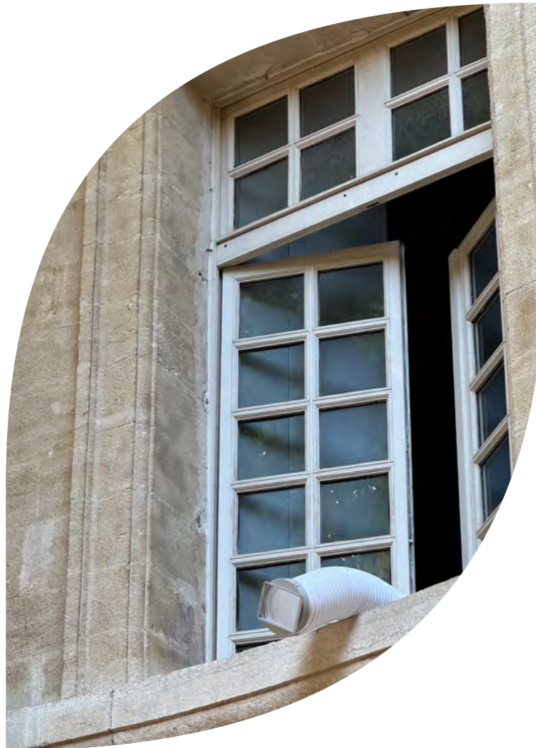
Festival d'Avignon, Cloître Saint-Louis, Bureaux administratifs : rejet extérieur d'une clim mobile à travers une fenêtre ouverte : un montage contre-productif.
